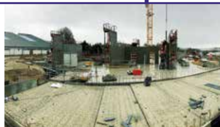
Coulage des planchers préfabriqués
