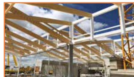
Pose de la charpente
