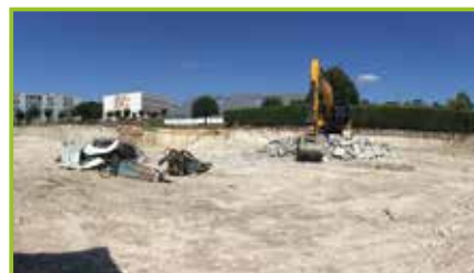
Préparation des plateformes des bâtiments
